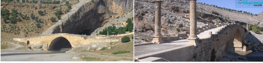
Şekil 1. Adıyaman Cendere köprüsü genel görünüşü
