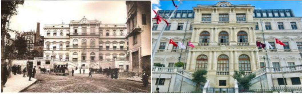
Şekil 15: Altıncı Daire-i Belediye (1857) ve Restore Çalışması
