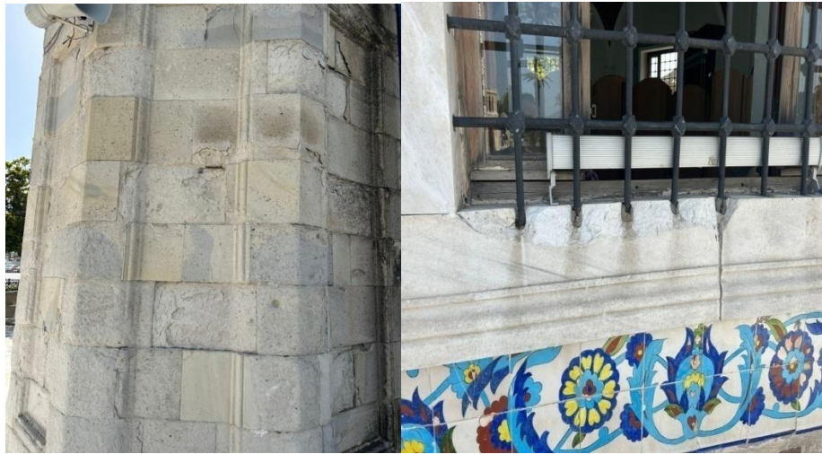
Şekil 8:Dış Duvarda Yer Alan Eleman Kayıpları (Kaynak: Kişisel Arşiv).
