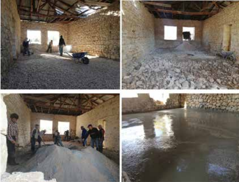
Görsel 15: Çaltıbozkır Köyü Sina İlkokulu Derslik Zemin Yenileme Çalışmaları (Kavas, 2022)
