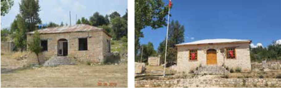
Görsel 18: Çaltıbozkır Köyü Sina İlkokulu Güney Cephe Onarım Öncesi-Sonrası (Kavas, 2020-2022)
