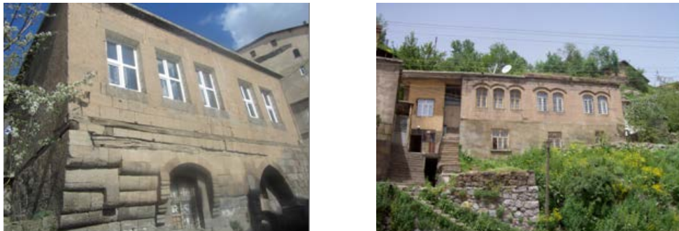
Şekil 2. Bitlis ili yığma yapı örnekleri
