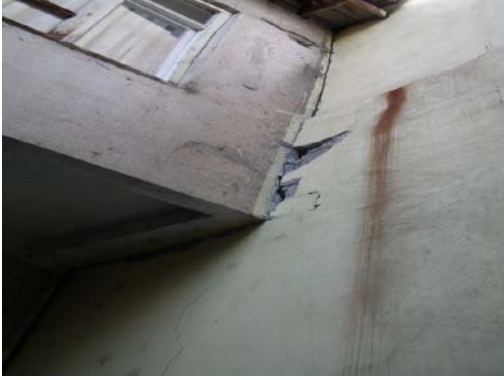
Bitişik nizamda çekiçleme etkisi
