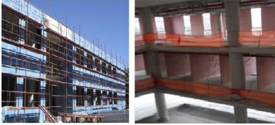
Şekil 6. Dış Cephe ve İç Bölme Kuru Duvar İnşaatları
