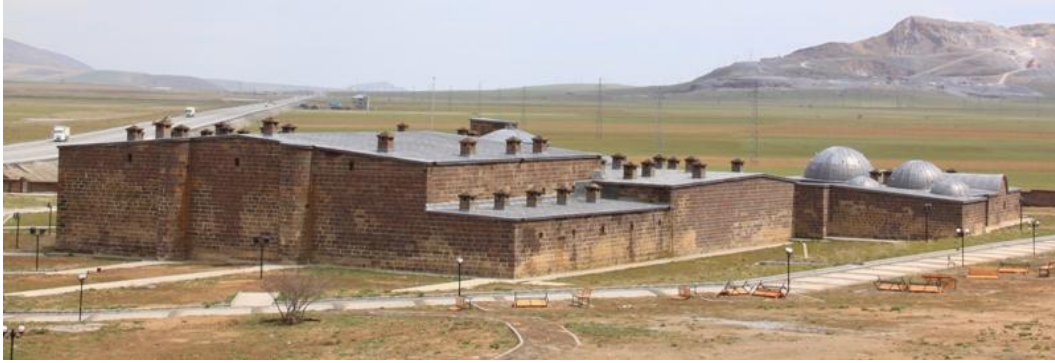
Resim-4 Restorasyon Sonrası Arka Cepleden Genel Görünüm
