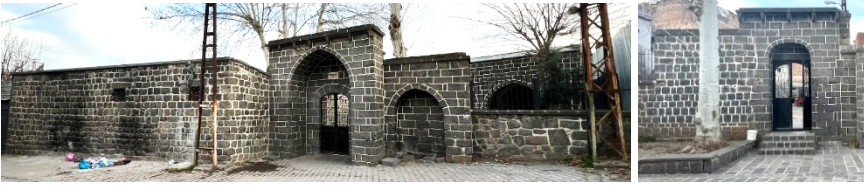
Şekil 17. İbrahim Bey Mescidi Sokak Cephesi
