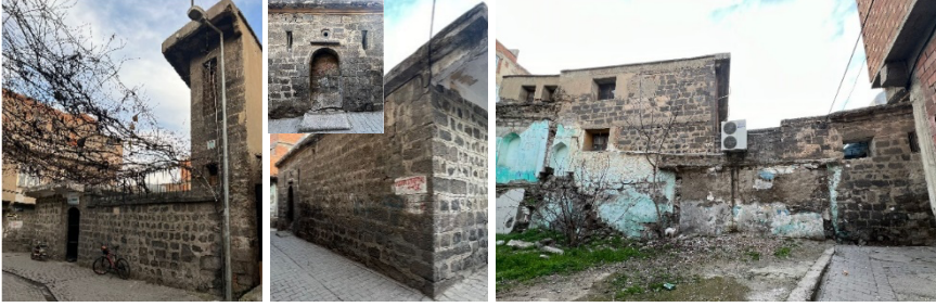
Şekil 24. Kaşık Budak Mescidi Sokak Cephesi
