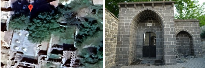
Şekil 14. İbrahim Bey Mescidi Konumu (Google Earth) ve Giriş Cephesi (2025)
