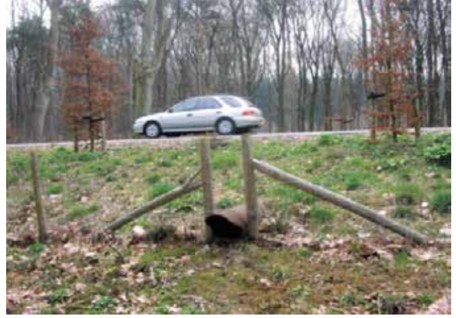
Şekil 10. Küçük Boyutlu Alt Geçit
