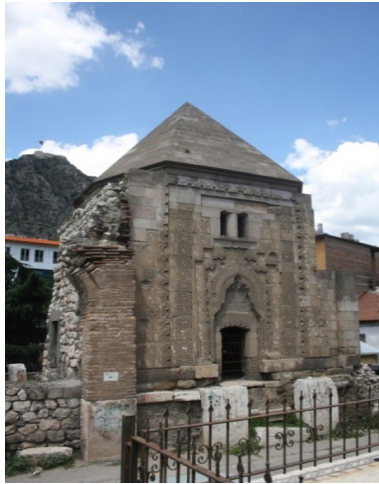
Fotoğraf:1 -Halifet Gazi Türbesi, Güney Cephe (İ.Gültekin, 2017)
