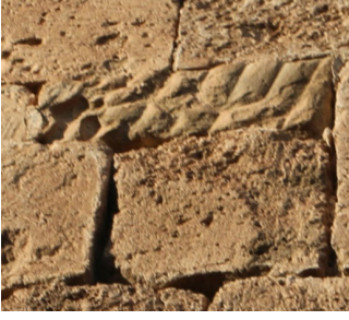
G. 6a: Cami Güney Cephesi 2 No.lu Taş (R. Yelen, 2024)
