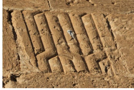
G. 6b: Cami Güney Cephesi 3 No.lu Taş (R. Yelen, 2024)
