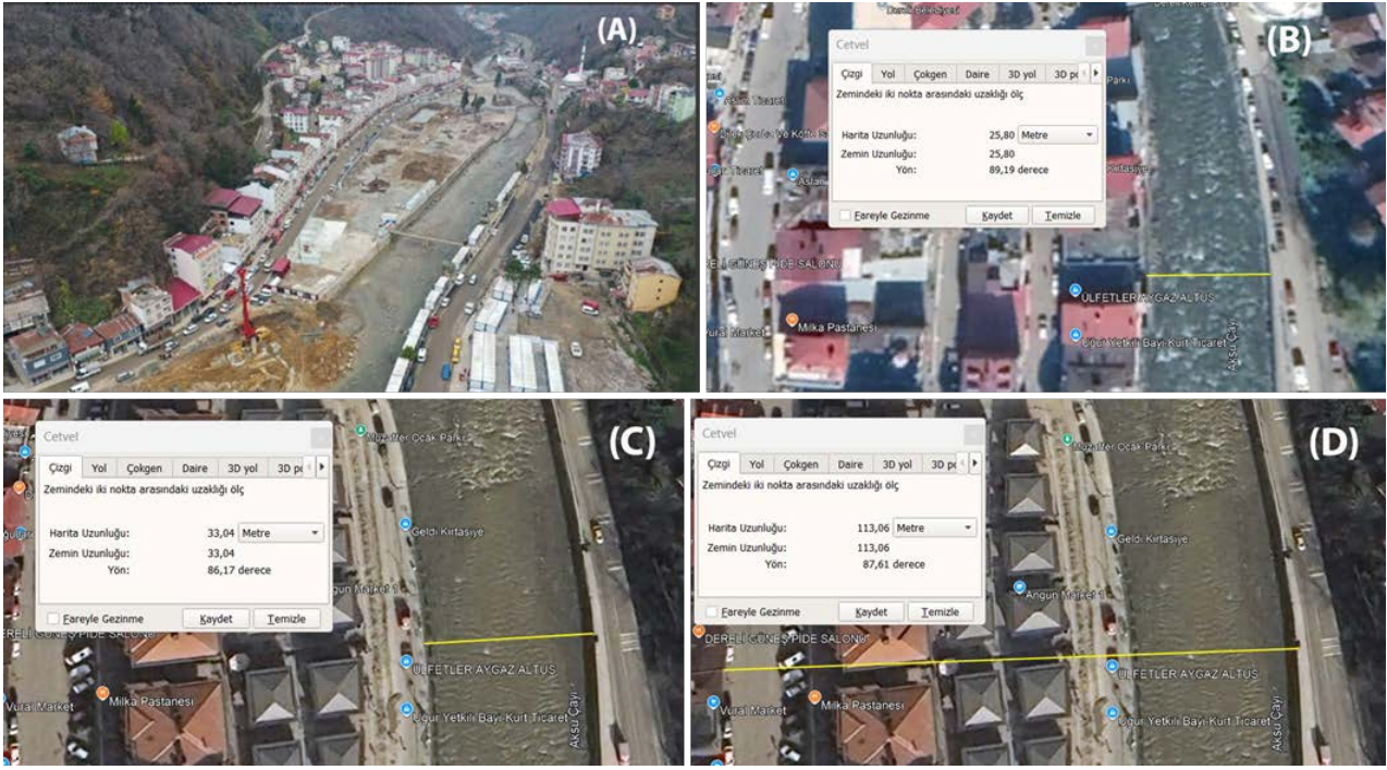
Foto 6: 22 Ağustos 2020 selinin Dereli'deki hasar temizliđi sonrasında Aksu Çayı yatađı daha net olarak görölmektedir (URL 8). Sel öncesinde 25-26m olan kanal genişliđi, sel sonrasında 35-36m ye artırılarak yeniden yapılmıřtır. Oysa sel ile tahrip olan ve yüksek su seviyesi akıřına ait temizliđi yapılan kanal genişliđi 113-120m genişliđindedir. Morfolojik veriler; dođal yatak genişliđinin bundan daha fazla olduđuna iřaret etmektedir (ölçüm görüntüleri Google Earth Pro uygulamasından temin edilmiřtir) / Photo 6: The Aksu Stream channel can be seen more clearly after the damage cleanup of the August 22, 2020 flood in Dereli (URL 8). The channel width, which was 25-26m before the flood, was increased to 35-36m after the flood. However, the width of the channel that was destroyed by the flood and cleaned for the high water level flow is 113-120m wide. Morphological data indicate that the natural channel width is much larger than this (measurement images were obtained from Google Earth Pro application).
