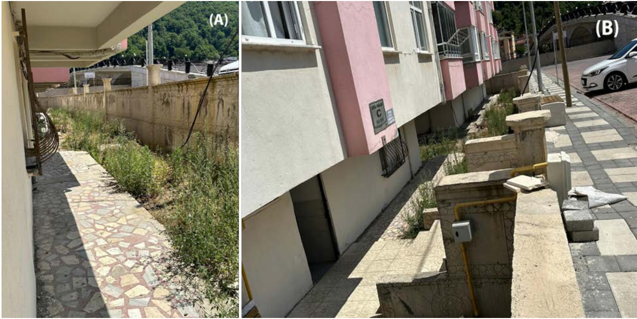
Foto 4: Ezine ayı'nın Bozkurt yerleşmesinde Ezine ayı yatağı içinde dolgu ile yapılan yol kotu yükseltmeleri ve yol platformundan -2,4 m düşük kotta kalan bina girişleri. Bu binaların giriş katları yol kotunun altındadır. Olası bir taşkın halinde binaların giriş katları tamamen su altında kalacak ve tahliye problemi yaşanacaktır.
