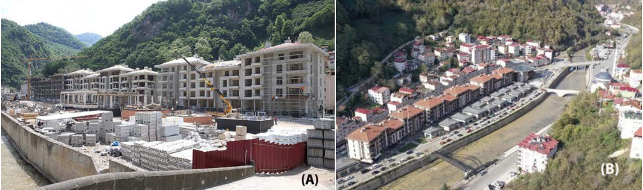
Foto 7: 22 Ağustos 2020'de yařanan sel afetinin ardından, Dereli ilçesinde, TOKİ tarafından yeniden yapılan konutlar ve iř yerleri ile diđer kamu binaları büyük oranda yine Aksu Çayı'nın dođal yatađlı içine inřaa edilmiřtir (URL 9, URL 10) / Photo 7: After the August 22, 2020 flood disaster, the residences, workplaces and other public buildings reconstructed by TOKİ in Dereli district were largely built in the natural channel of Aksu Stream (URL 9, URL 10).
