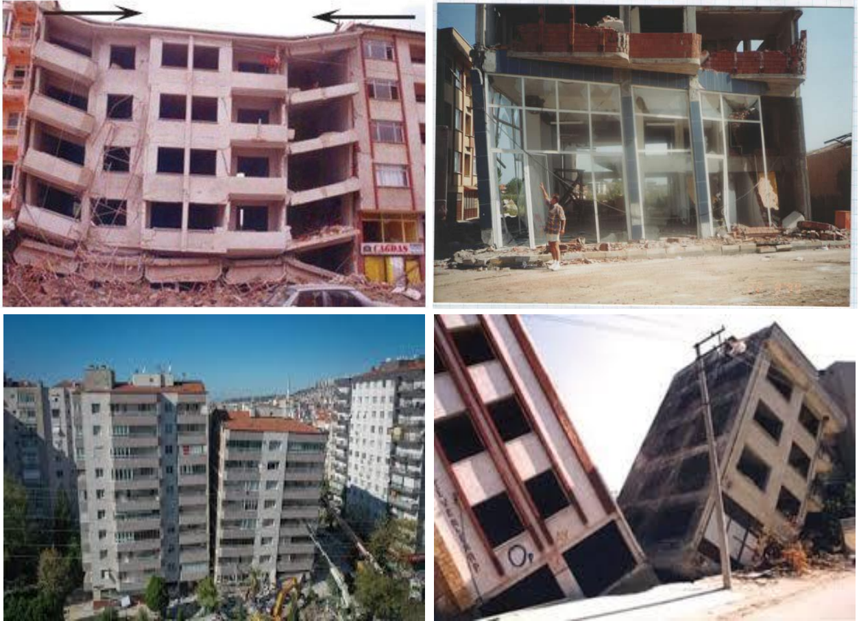
Şekil 7: Zayıf kat ve çekiçleme etkisi.
