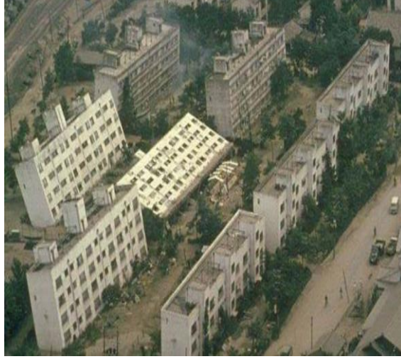
Şekil 2: 1964'te gerçekleşen Nigata depreminde sivilaşma nedeniyle yan yatan binalar.
