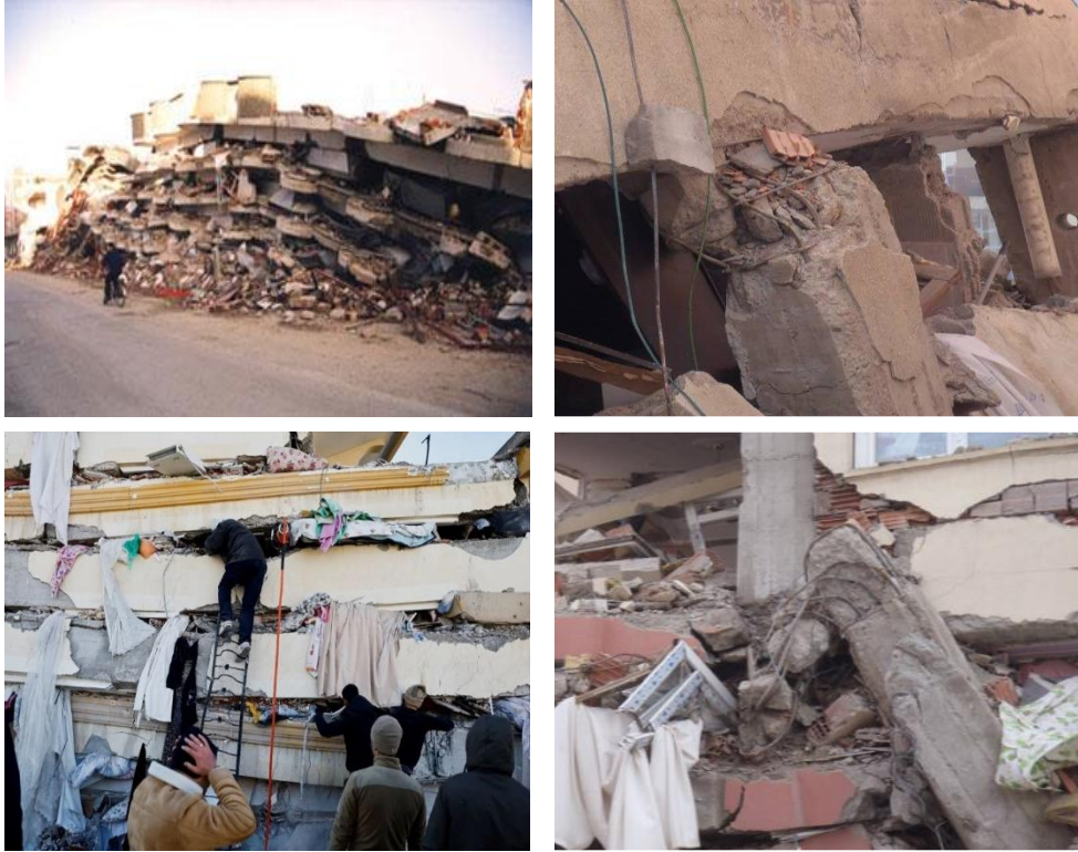
Şekil 5: Erciş, Merkez, Güçlü kiriş zayıf kolon davranışı ağır hasar almış kolon üst ucu.
