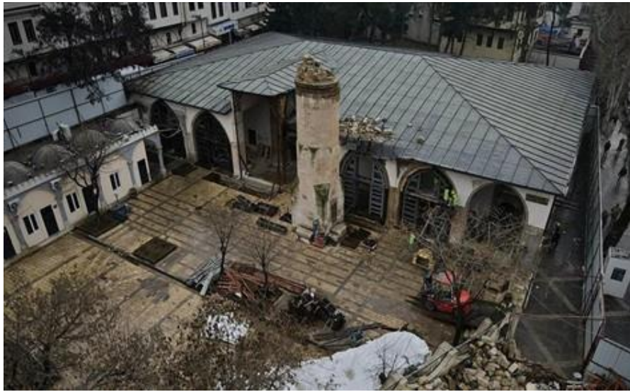
Fotoğraf 3. Ulu Cami 6 Şubat 2023 Depremleri Sonrası Görünüm
