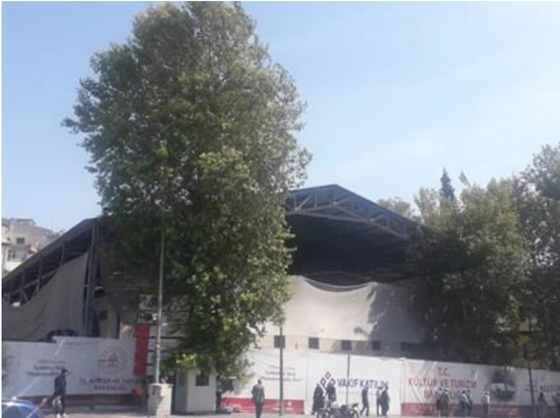
Fotoğraf 4. Ulu Cami Restorasyon Çalışması
