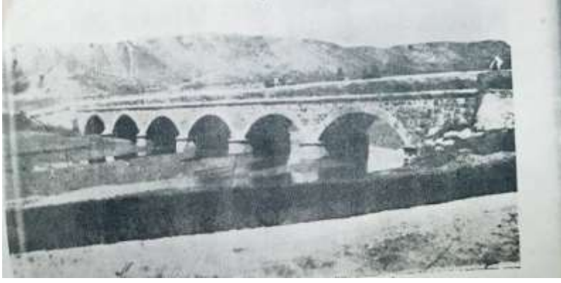
Resim 4-A: Havser üzerindeki kemerler -Koyuncuk Tepesi yakınında-. Bu kemerler 1955 yılında yıkılmıştır.
