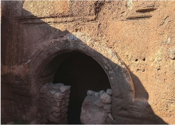
a. Yapının Kemerli Girişi
