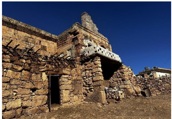
b. Yapının güneybatıdan görünümü
