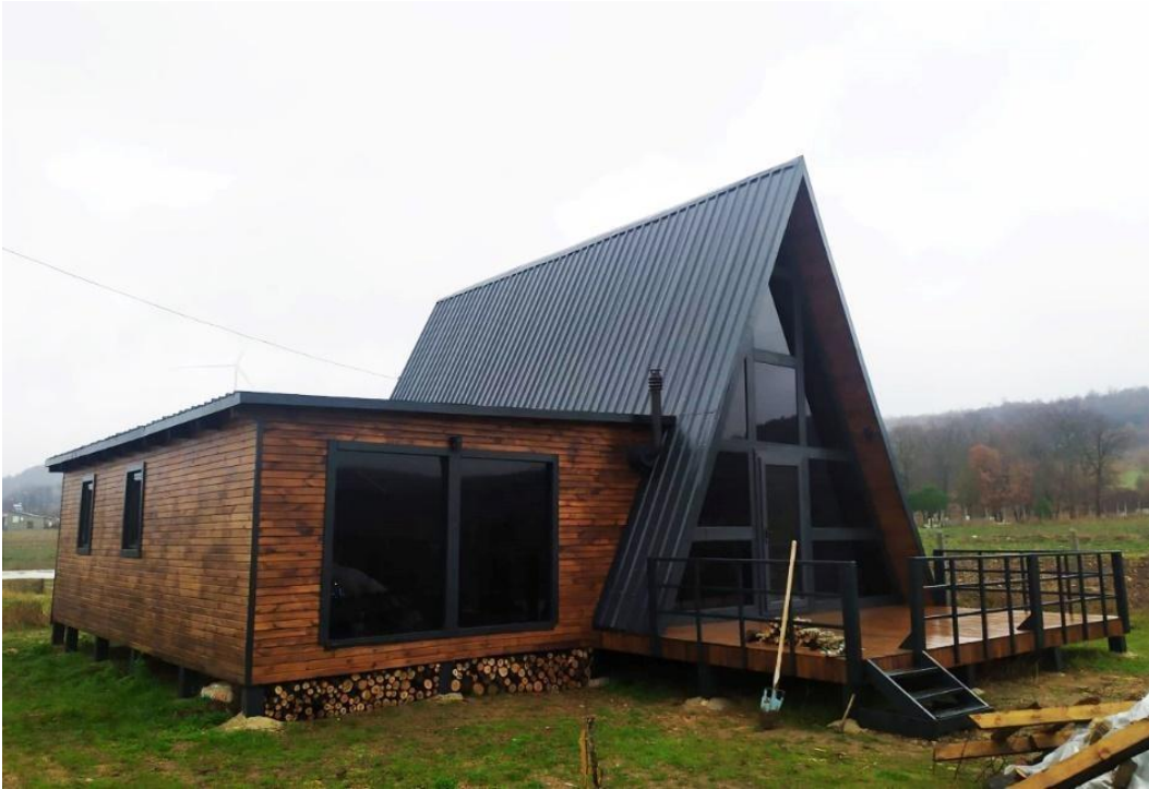
Şekil 10. Ek bölüm ve dış cephe (yazar arşivinden).
