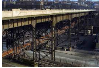
Şekil 25. Marsupial Köprüsü (URL-19)
