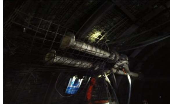
Şekil 11. Venturi sisteminin boru şebekesine monte edilmiş hali. Figure 11. Venturi system mounted on the pipe network.
