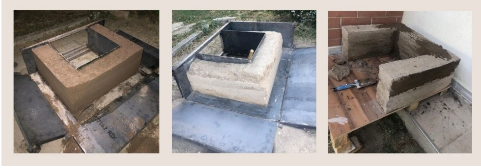
Görsel 10. Kerpiç bloğun kalıptan çıkarılması aşaması.
