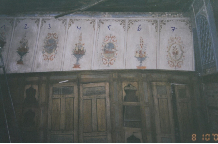
Resim 7 Veli Şemseddin Mahallesi'ndeki Ev.
