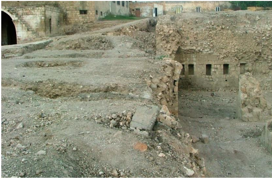
Res. 26: Kuzey ve güneydeki avluları birbirine bağlayan duvarın güney yüzü
