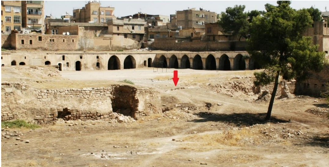
Res. 27: Güney avlunun kuzey duvarı ve rampa olarak kullanılan birim
