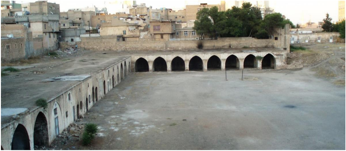
Res. 5: Kuzey avlu, doğu ve kuzey kanat
