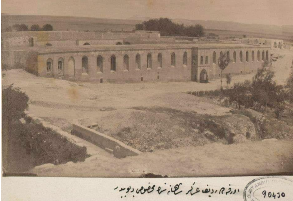
Res. 22: Abdülhamid Albümleri’nde bulunan yapının güney cephesine ait resim (Kürkçüoğlu 2009)
