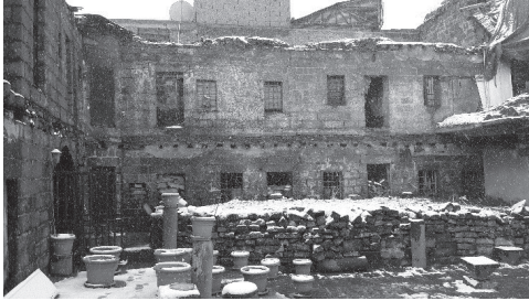
Şekil 5. Çifte Han avlusu, yapı terk edilmiş bir durumda.
