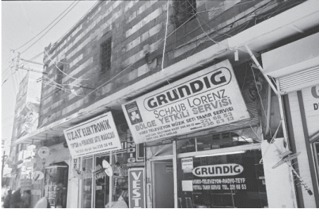
Şekil 10. Hasan Paşa Hanı kuzey cephesi.
