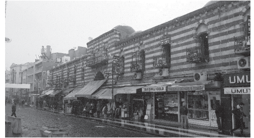
Şekil 6. Hasan Paşa Hanı Gazi Caddesi, batı cephesi.
