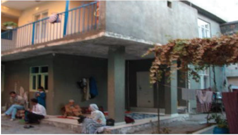
Resim 2. Geleneksel evin avlusuna eklenen betonarme yapı
