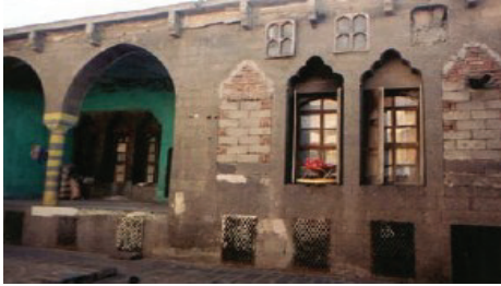
Resim 8. Pencere boşluklarının tuğla ile kapatılması
