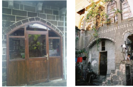
Resim 10. Yarı açık mutfağın ahşap ve sac ile kapatılması örnekleri
