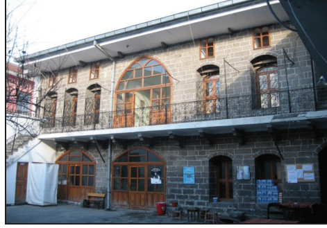
Resim 9. Eyvan kapatma ve malzeme değişikliği
