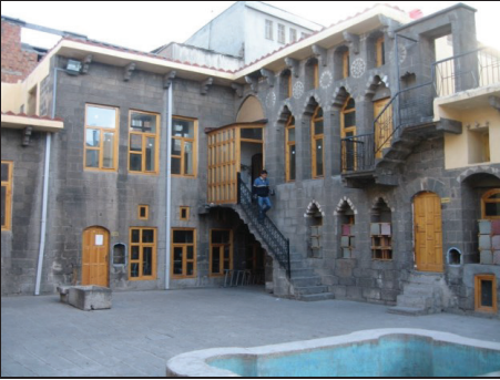
Resim 12. Ahşap elemanların, malzeme tür, biçim ve boyutlarına uyulmadan yapılan değişimler
