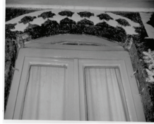
DOĞRAMASI DIŞTA BULUNAN PENCERE
