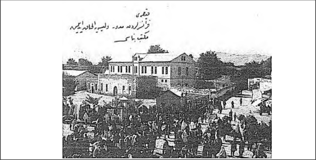
Fotoğraf 3. 1927 Yılında Kayseri Lisesine İlhak Edilen Cizvit Mektebinin Görünüşü(Özbek, 2010, s. 304)
