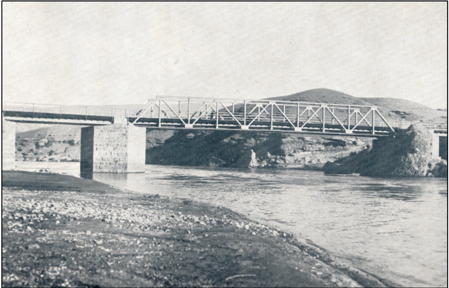
Resim 6: 1937’de Yapılan İliç Köprüsü 100
