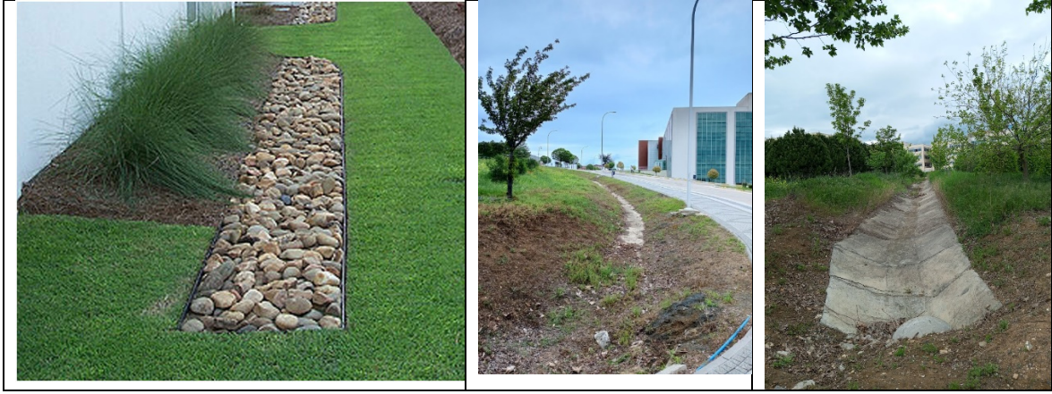
Şekil 5. Sızma hendeği için örnek uygulama ve önerilen alan düzenlemesi.
