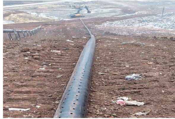
Şekil 5 Gaz üretimi için atıkların rigollerde depolanması
