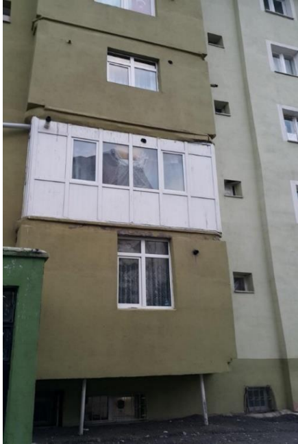
Şekil 6. Dış cephe kapatmak suretiyle odalara katılan balkon uygulaması
