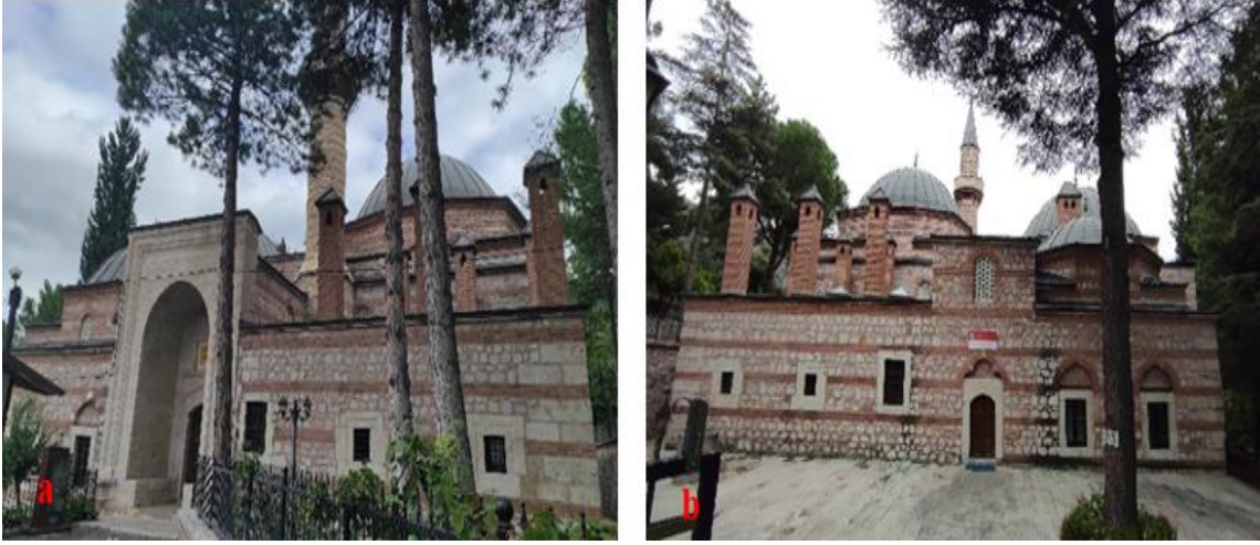
Şekil 12: Amasya Yakup Paşa Zaviyesi batı giriş cephesi (a) ve doğu cephesi (b) (Kartal, 2024).
