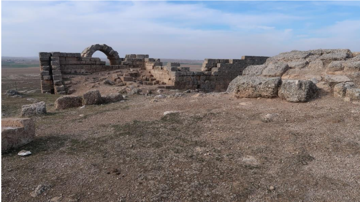
Şekil 7: Kalenin çift cidar duvar örgüsünden kalıntılar (08.01.2021)
