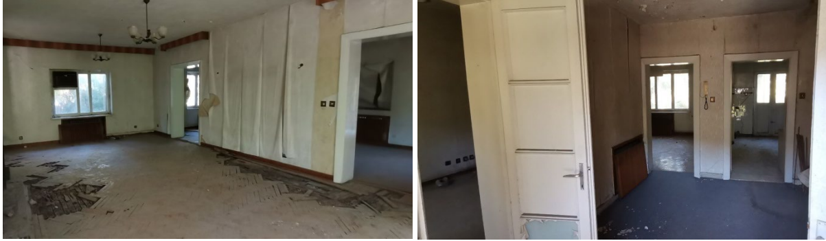
Şekil 7. A Blok iç mekan mevcut durum (Current condition of the interior of Block A)
