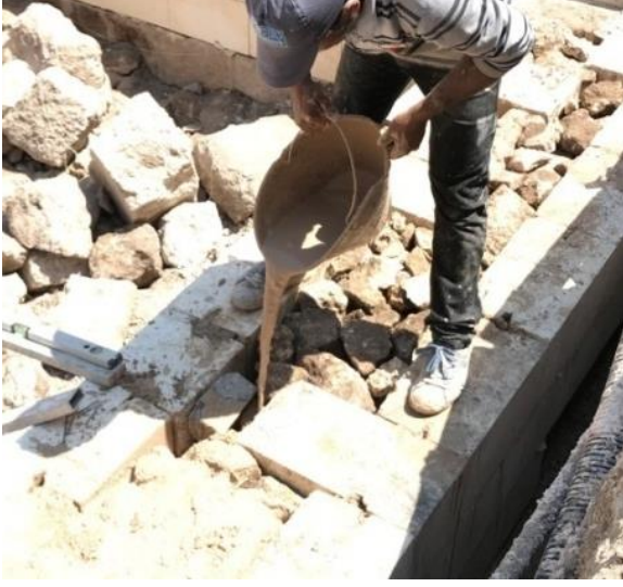
Şekil 7: Üç cidarlı duvar yapım aşamaları
