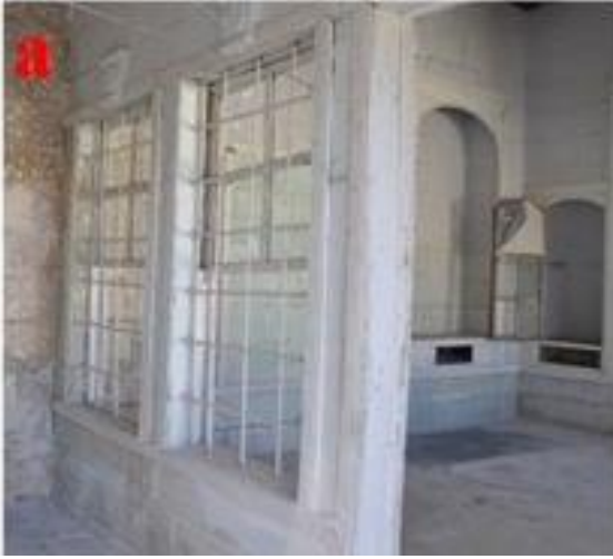
Şekil 6: a. b. İç mekânlarda kullanılan "tek cidarlı duvar" örnekleri
