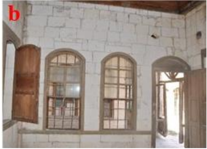
Şekil 6: a. b. İç mekânlarda kullanılan "tek cidarlı duvar" örnekleri
