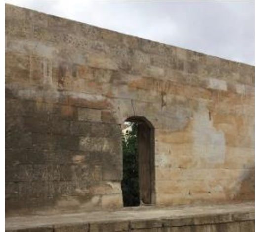
Şekil 13: İnce yonu taş duvar örneği
