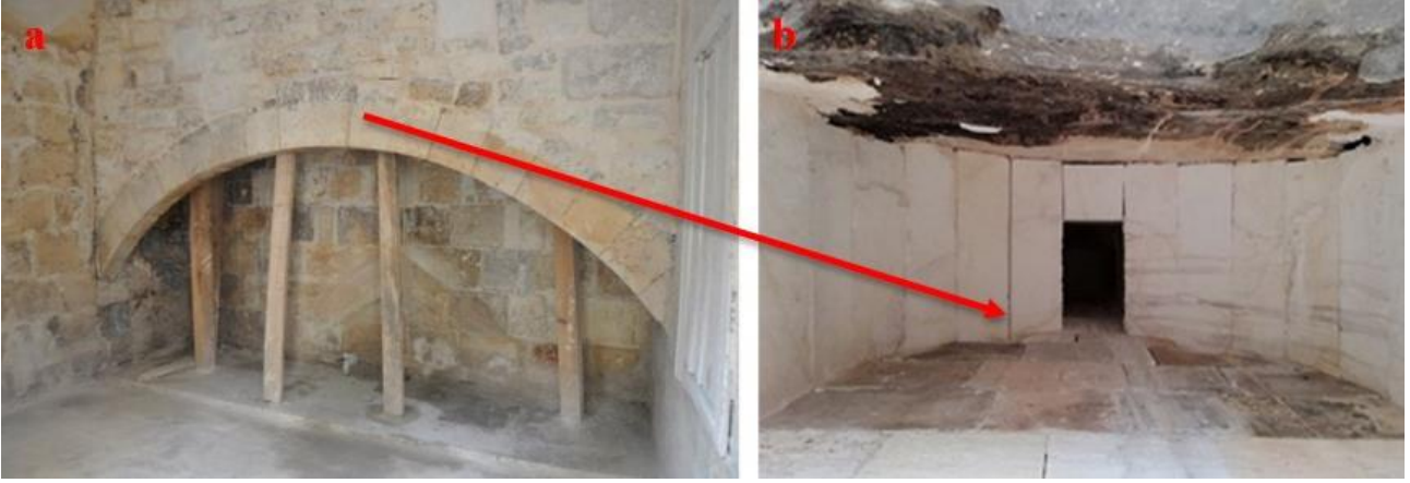
Şekil 26: a. Ocak, b. Ocak içerisindeki baca boşluğunun içten görünümü
