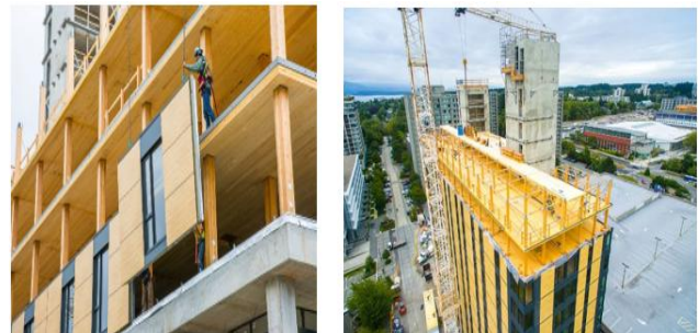
Figure 2. Brock Commons Tallwood House (Vancouver, Canada) (URL-2).
