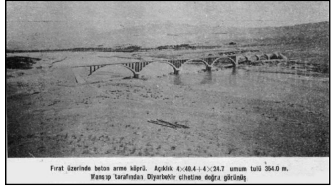
Şekil 6. Tamamlanan ilk Fırat Demiryolu Köprüsü (T.C. Nafia Vekâleti, 1933, s. 70).
