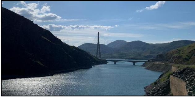
Şekil 5. Kömürhan Köprüsü (Fotoğraf: M. AYDIN, 29.04.2023).
