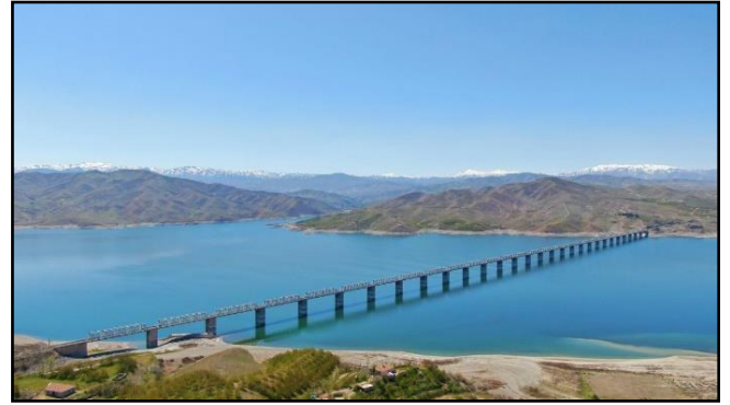
Şekil 7. Fırat Demiryolu Köprüsü (Kantarcioglu, 2022).
