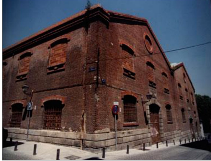
Resim 1. Caixa Elektrik Santrali'nin Dönüşüm Öncesi Görünüşü (Herzog & de Meuron)
