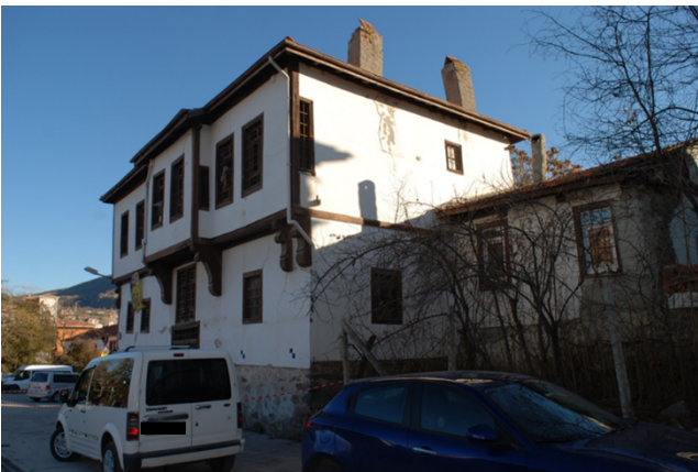
Şekil 1. Konutun ön ve sağ cephe görünümü.
