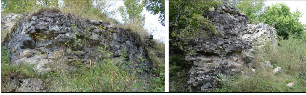
Görsel 17: Yedigöller Kalettepe Kalesi ve Halıhisarı Kalesi Duvar Örgüsü Detayı (E. Verim)
