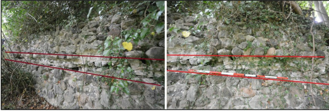
Görsel 25: Güney Sur Duvar Örgüsündeki Yatay Ahşap Hatıl Detayı (E. Verim)
