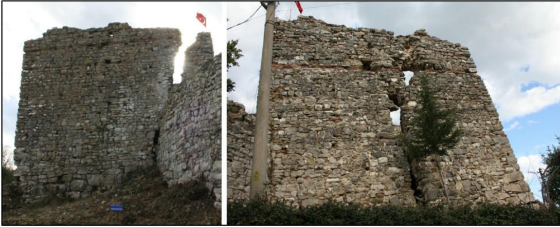
Görsel 11: Restorasyon Öncesi, B1 Kuzey ve Güney Duvarı (E. Verim)
