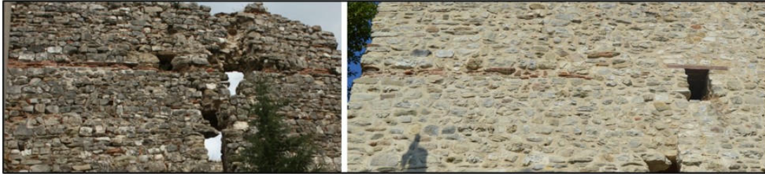
Görsel 15: B1 Güney Duvarındaki Tuğla Bantların Restorasyon Öncesi ve Sonrası Detay Görünüşü (Konuralp Müzesi Arşivi ve E. Verim)
