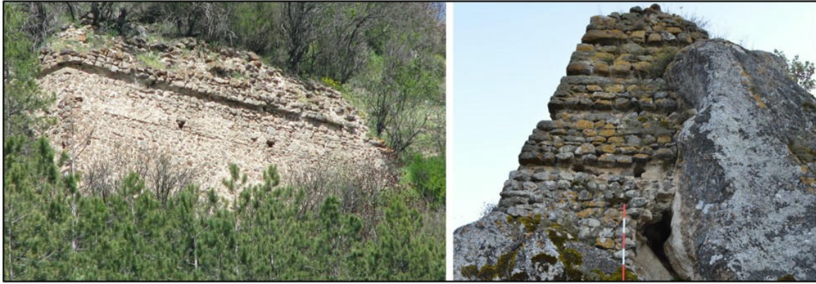
Görsel 27: Modrene Kalesi ve Akçaşar Kalesi Surlarındaki Yatay Ahşap Hatıl Boşlukları (E. Verim)
