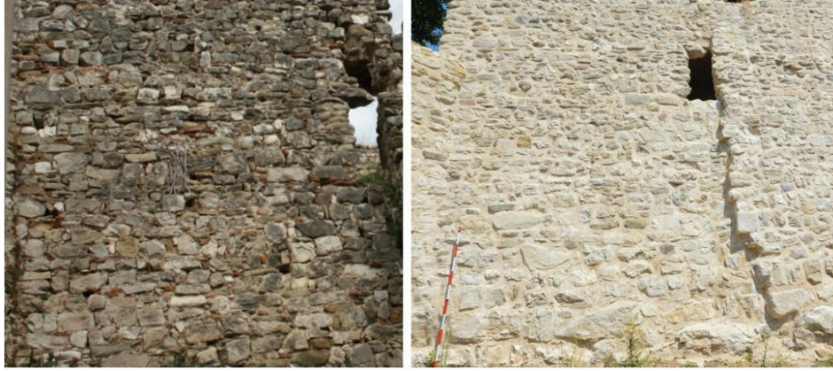
Görsel 14: B1 Duvarı Restorasyon Öncesi ve Sonrası Detay Görünüşü (Konuralp Müzesi Arşivi ve E. Verim)
