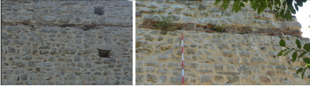
Görsel 16: B1 Kuzey ve Batı Duvarındaki Tuğla Bantlardan Detay Görünüş (E. Verim)
