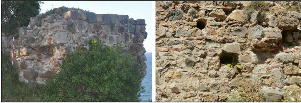
Görsel 18: Güzelcehisar Kalesi B1 ve Gerede Keçi Kalesi Güneydoğu Kapı Duvar Örgüsü Detayı (E. Verim)
