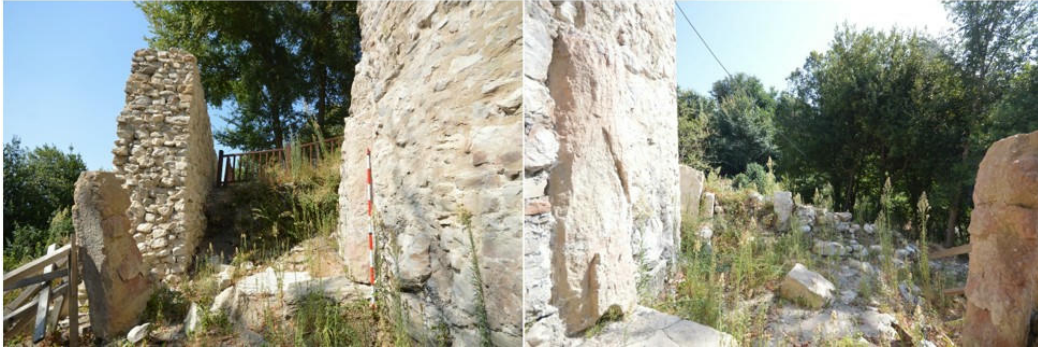
Görsel 6: Güneybatı Kapının Dıştan ve İçten Genel Görünümü (E. Verim)
