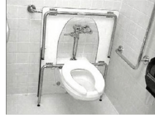
Şekil 5. Destek aparatlı klozet, A. Kapalı hali, B. Açık hali [13 ve 14].
