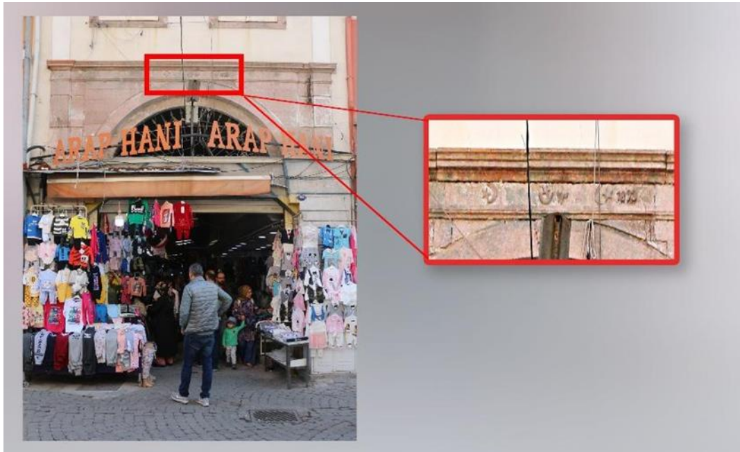
Şekil 3. Arap Hanı’nın kuzey cephesinden görünümü (2019)
