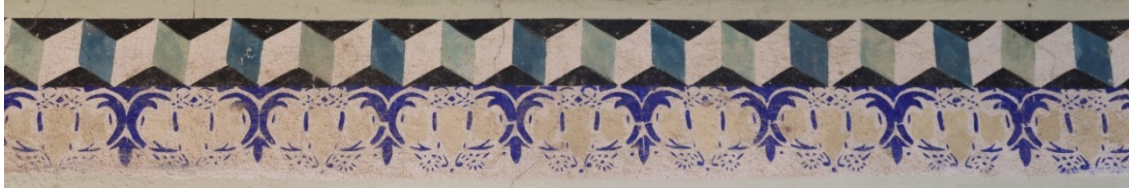
Fot. 30: Dış Cephe Geometrik Bezeme Kuşağı
