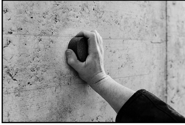
Şekil 2.2. Yüzeyi pürüzsüz hale getirme işlemi
