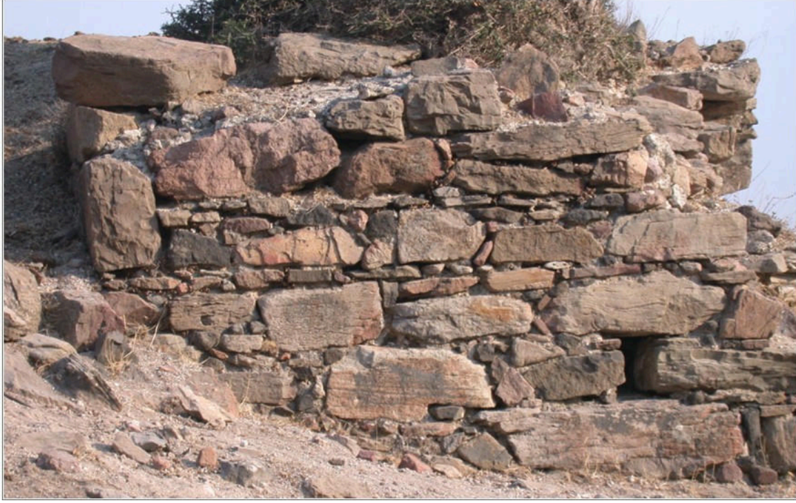
Görsel 11: Batı cephenin duvar örgüsü (Tok, Manisa Yakınlarında Bir Ortaçağ Kalesi, 151)
