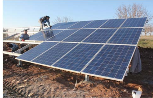
Şekil 7. Fotovoltaik panellerin araziye montajı
