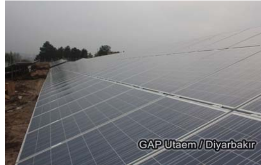
Şekil 8. GES kurulununun tamamlanması
