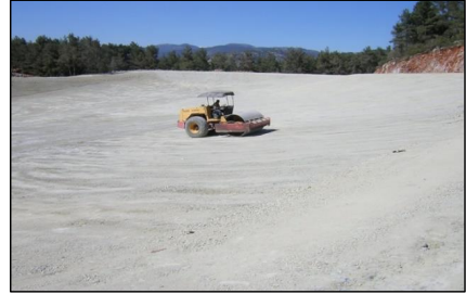
Şekil 1. Kil geçirimsizlik tabakasının sıkıştırılması işlemi
