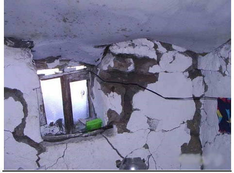
Şekil 5. Tipik bir köy konutunda meydana gelen bir hasar örneği (Viranşehir)
