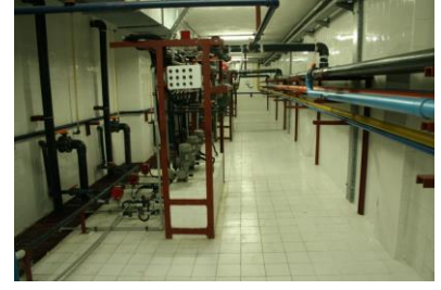
Şekil 18. Kimyasal doz pompaları
