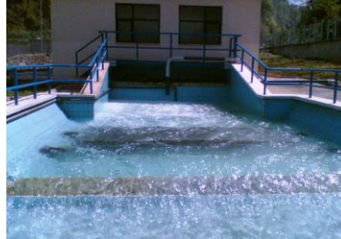
Şekil 5. Enerji kırıcı ve giriş
