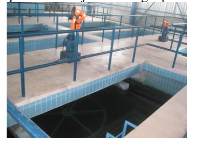
Şekil 9. Yavaş karıştırıcılar
