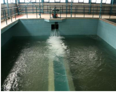
Şekil 13. Filtre havuzu
