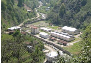
Şekil 1. Andon Su Arıtma Tesisi
