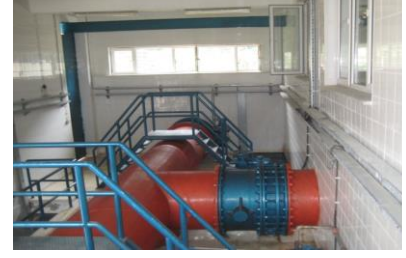
Şekil 12. Filtre by pass odası
