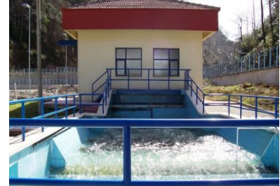
Şekil 6. Enerji kırıcı ve giriş
