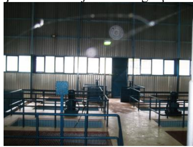
Şekil 8. Hızlı karıştırıcılar
