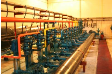
Şekil 16. Seyreltme pompaları
