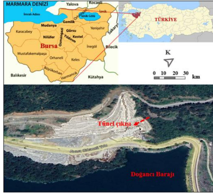
Şekil 1. Doğancı Tüneli'nin konumu. Bursa İli merkez ilçesi Osmangazi'den Orhaneli İlçesi kara yolunun Km:8+750 ve Km:13+205.83 arasındaki Doğancı Köyü (The location of the Doğancı Tunnel. The Doğancı Village between Km: 8+750 and Km: 13+205.83 of the highway from Osmangazi, the central district of Bursa Province, to Orhaneli District)
